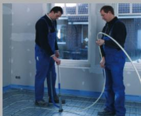
Das Tackerwerkzeug ermöglicht eine zügige und präzise Fixierung des Systemrohres auf dem Verlegeraster (5 cm).
