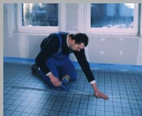
Nach vollständiger Verklebung aller Stoßkanten ergibt sich eine geschlossene Dämmschichtoberfläche.
